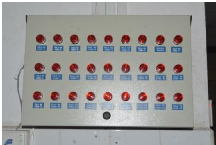
Fotografía 57 Sistema de alarmas individuales/cama, área de hospitalización
